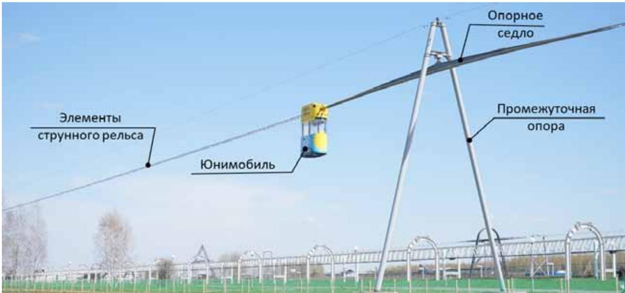
Рис. 2. Пример пятипролётной гибкой путевой структуры uST «Юнилайт» общей длиной 1120 м (г. Марьина Горка, Республика Беларусь; год строительства 2023)
