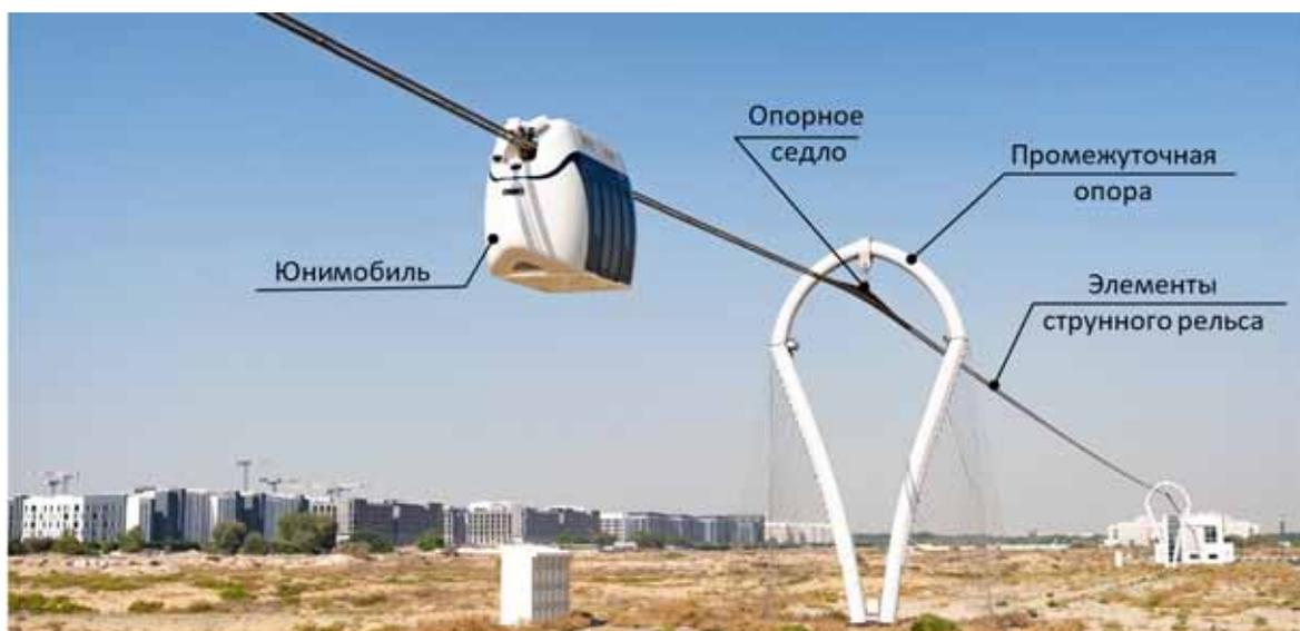
Рис. 1. Пример трёхпролётной гибкой путевой структуры uST общей длиной 400 м (100 + 200 + 100) в г. Шарджа, ОАЭ (год строительства 2019)
